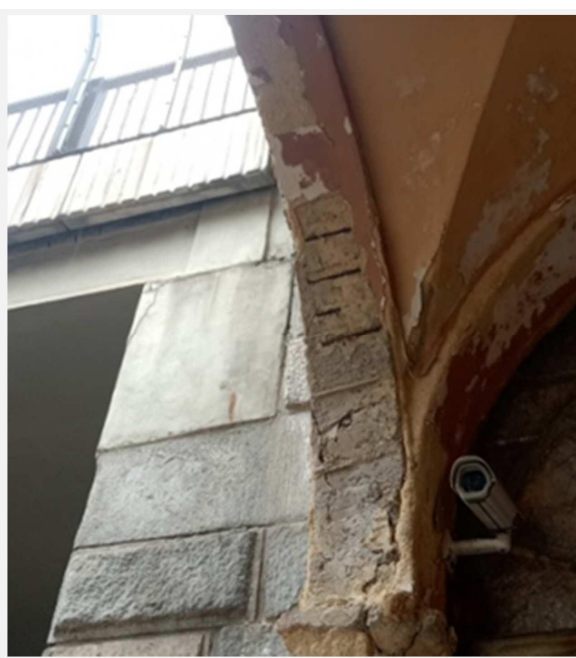
Obr. 2 Degradovaná část konstrukce sloupů a kleneb
