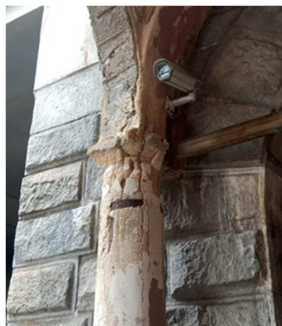
Obr. 4 Degradovaná část konstrukce sloupů a kleneb
